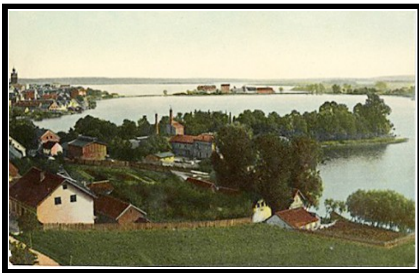
Budynki inwentarskie i zaplecze agralne Ełku (przeł. XIX/XX w.)
